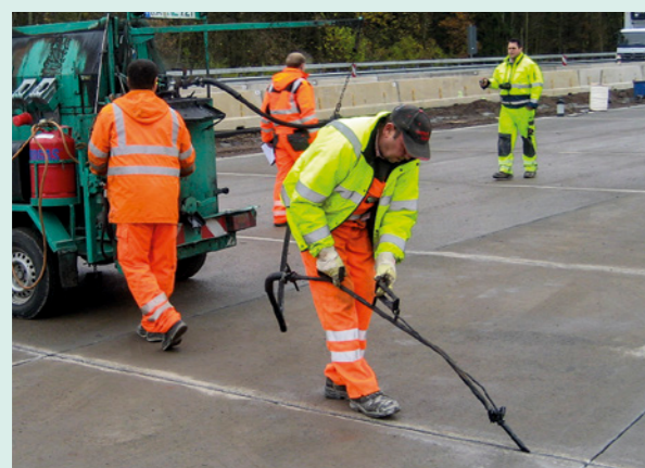
Einbringen der Fugenmasse
