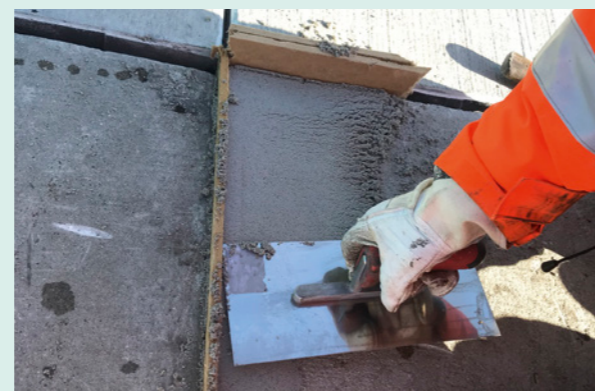
Einbau des Epoxidharzmörtels
