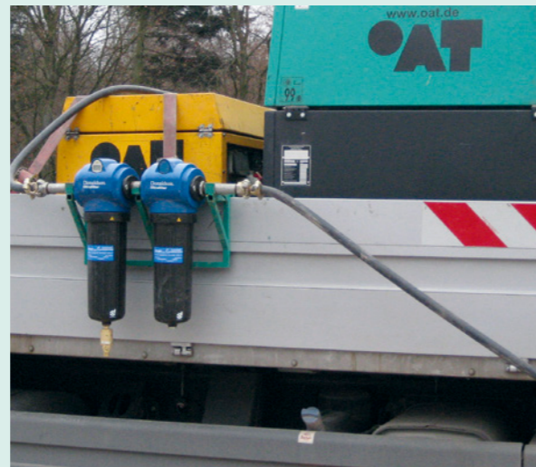
Bohren und Ausblasen mit ölfreier Luft
