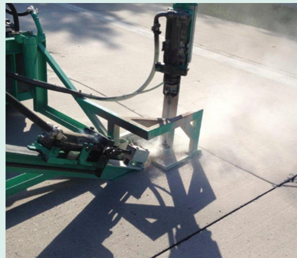
Senkrechte Vorbohrung
