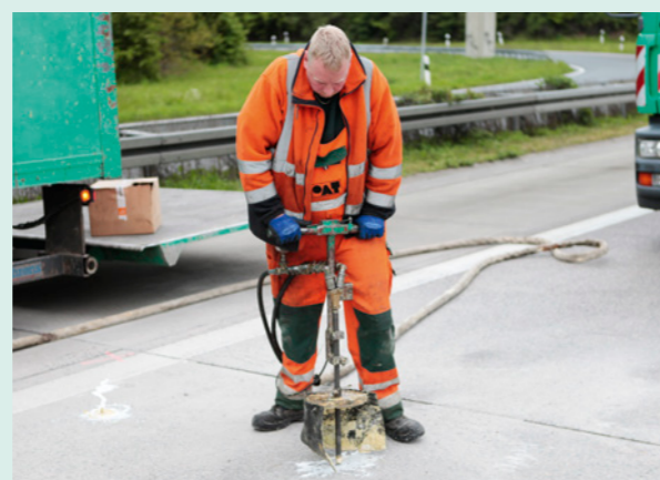
Unterpressen mit Injektionsmaterial
