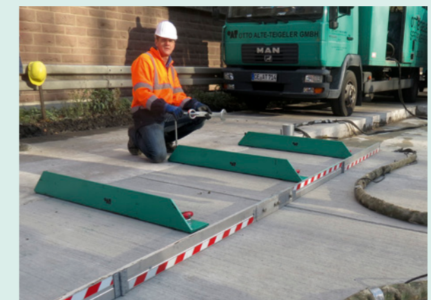
Höhenjustierung über benachbarte Platte
