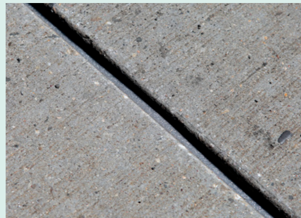
Vorbereitete Fuge mit Unterfüllstoff
