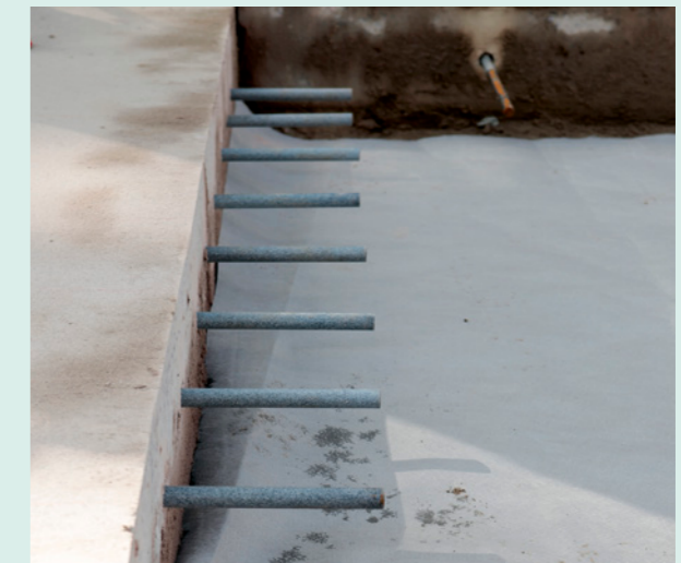
Querpressfuge mit eingebauten Dübeln
