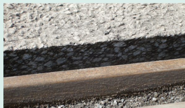
... gefräste Fugenflanke - das Korn liegt frei
