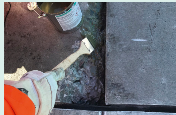
Auftragen des Haftgrundes
