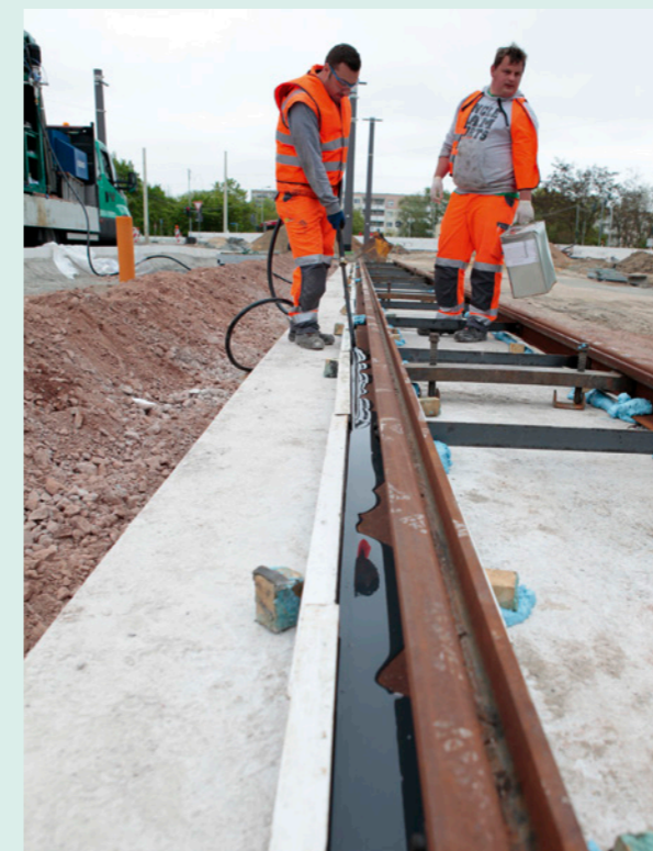
Einbringen des Untergrusses
