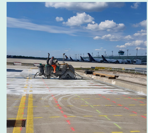
Trennschnitte auf Flugverkehrsflächen
