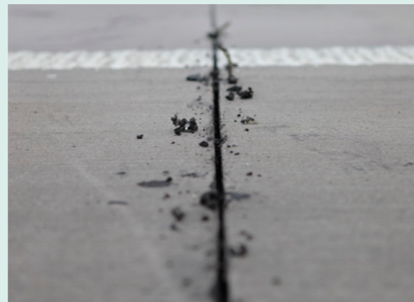
Ausgeräumte Fuge
