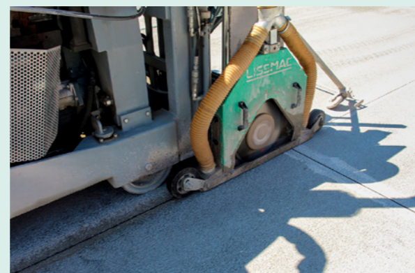
Einschneiden zuvor verlegter Profile
