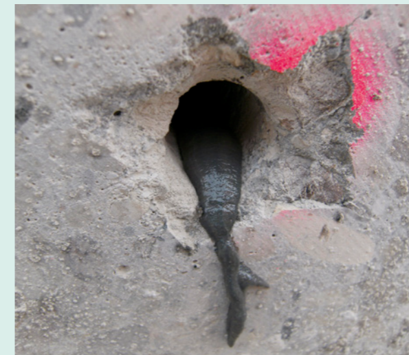
Mit Epoxidharzkleber gefülltes Bohrloch
