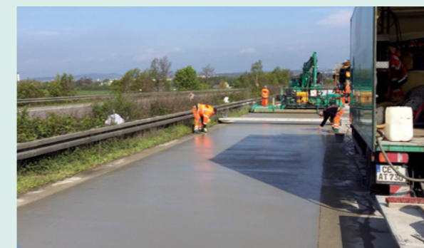
Streifenweiser Ersatz von Betonflächen
