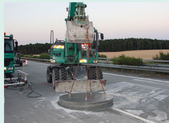
Einsetzen eines runden Fertigteils
