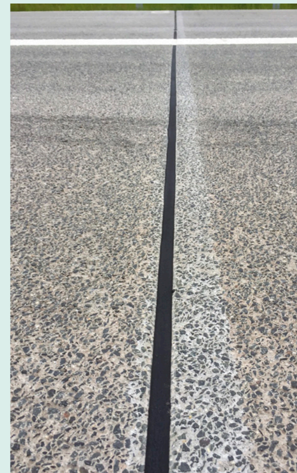
Bituminös verfüllte Raumfugen
