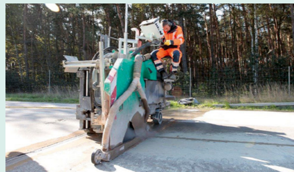
Trennschnitte entsprechend Deckenstärke
