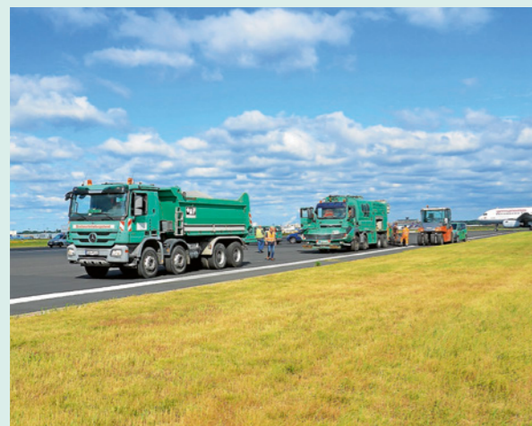
Hohe Tagesleistungen durch modernen DSK-AIR-Einbauzug
