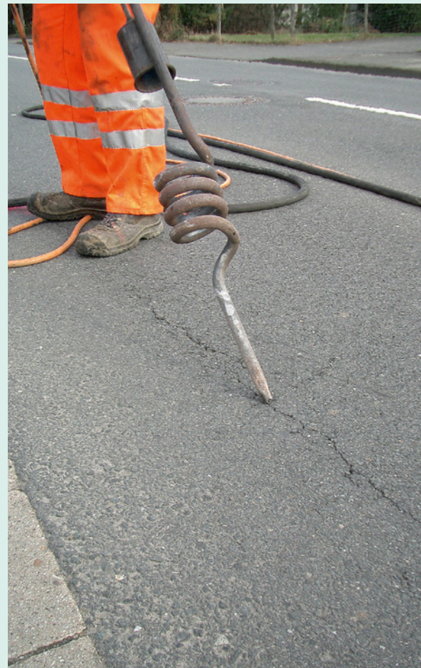
Ausblasen und Vorwarmen mit heier Pressluft
