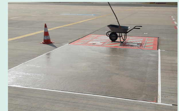
Grundierung für Oberflächenbehandlung
