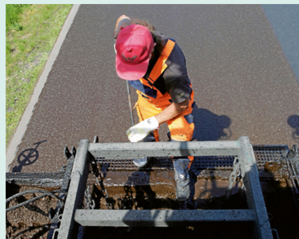
Entnahme von Rückstellproben zur Qualitätssicherung
