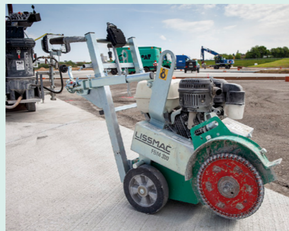
Brechen der Fugenkanten mittels Abfasmaschine und Diamantwerkzeug
