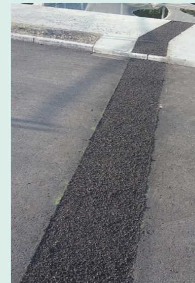
Fertiger Fahrbahnübergang
