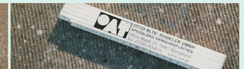
Fertige Grindingoberflächentextur
