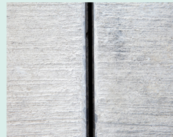
Fertig aufgeweitete Fugen mit Kerbschnitt, Fugenkammer und Fase
