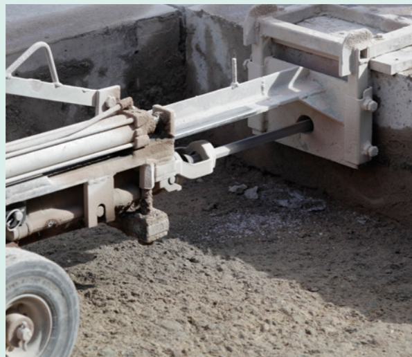
Bohren mit pneumatischem Handbohrgerät
