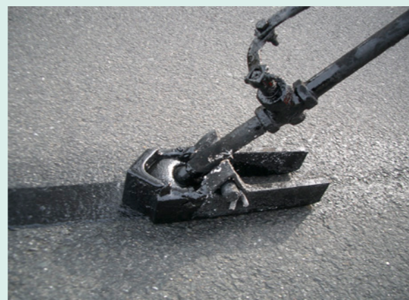
Aufbringen des Abdeckstreifens mittels Ziehschuh
