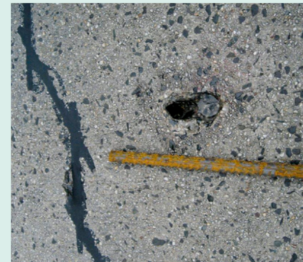
Gereinigtes Bohrloch mit Anker
