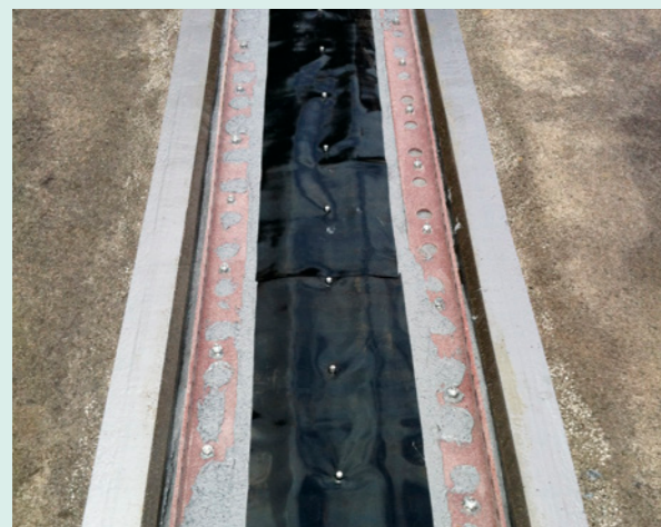
Fertig vorbereitete Belagsdehnfuge
