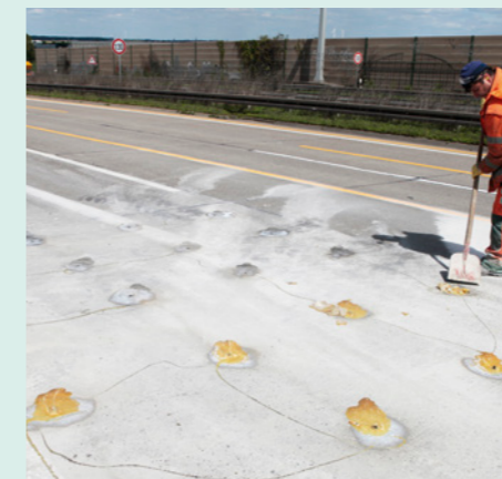
Fertig unterpresste Betonplatte
