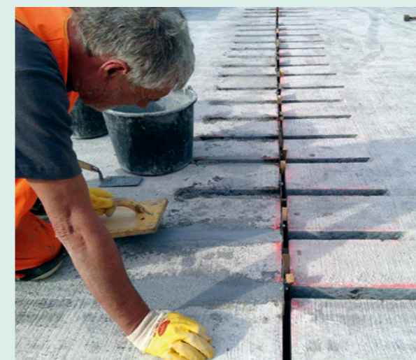
Einbau von Reaktionsharzmörtel
