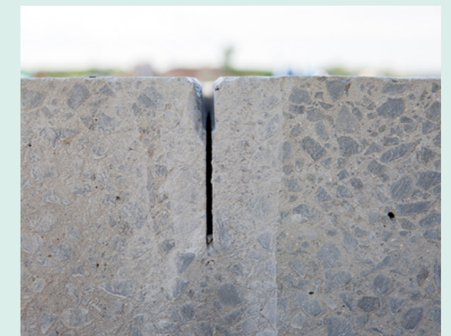
Seitenansicht der fertig aufgeweiteten Fuge mit Kerbschnitt, Fugenkammer und Fase
