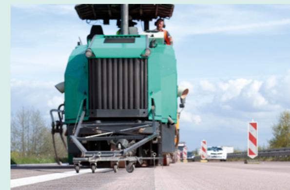
Bahnenweise Ausführung auf Autobahnen
