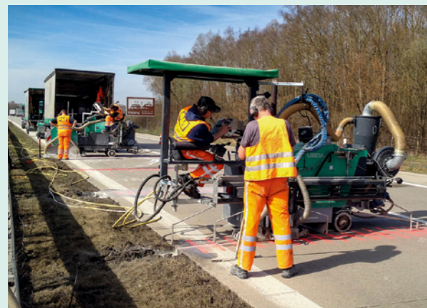
Vorschnitt und Herstellung der Raumfuge
