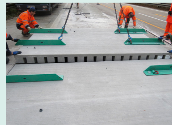
Fertigteile für Plattenersatz
