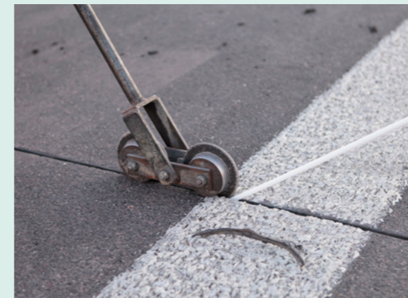
Einbringen des Unterfüllstoffes
