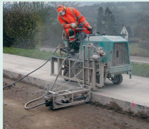
Bohren mit Anbausatz an Fugenschneider
