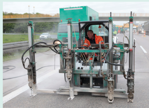
Injektionslöcher mit Mehrfachbohrgerät
