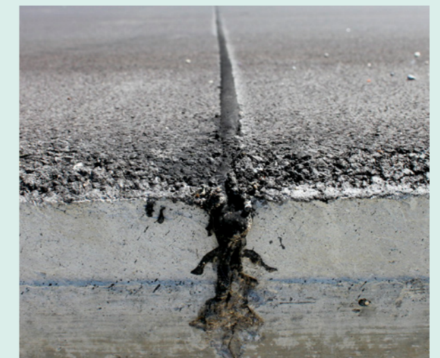
Fertige Fuge in DSH-V auf Beton
