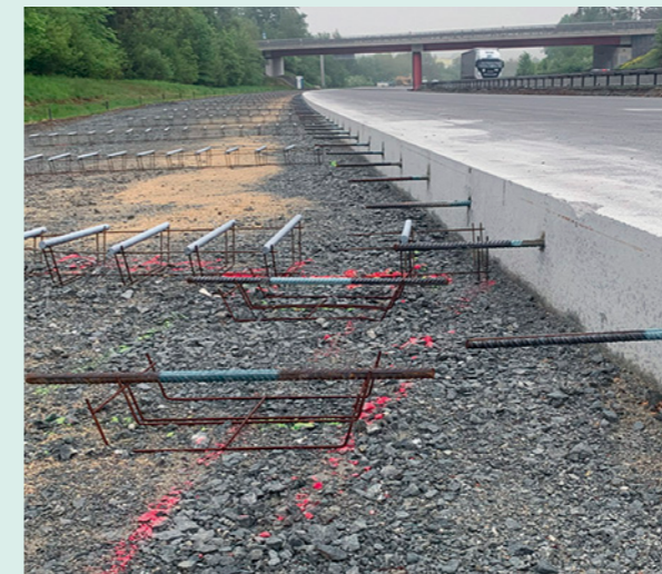
Anschlussverankerung in Längspressfuge
