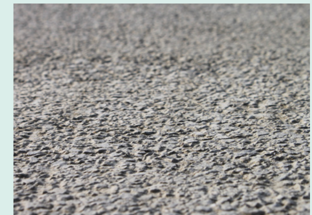
Fertige Oberfläche mit Waschbetontextur
