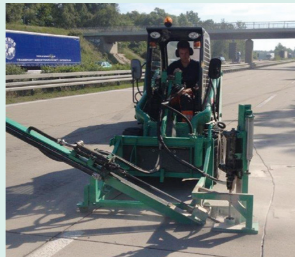
Herstellung der Schrägbohrung
