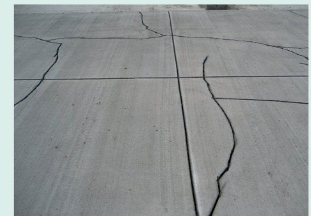
Vorbereitete Risse fur Fras-Verguss-Verfahren in Betonflachen
