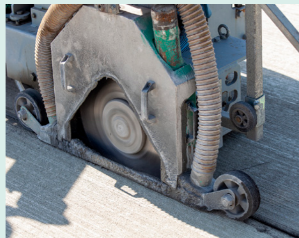
Einsatz von Diamantwerkzeugen und Direktabsaugung des Schneidschlammes
