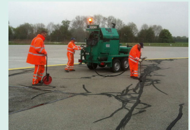
Aufbringen der Abstreuerung
