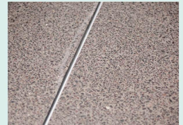
Fertig vorbereitete Fuge inkl. Unterfüllstoff
