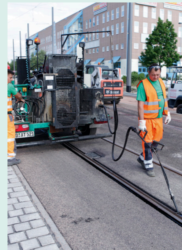
Verguss mit bitumenhaltiger Fugenmasse
