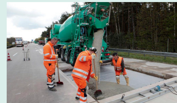
Einbau Schnellbeton
