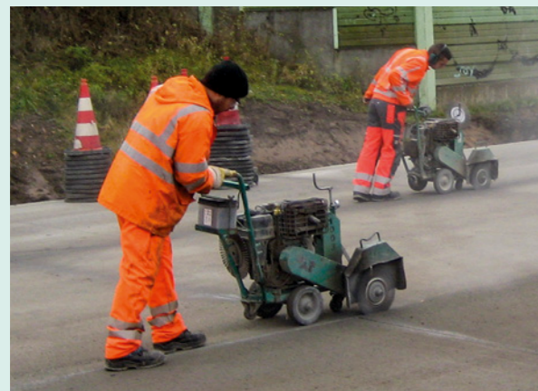
Reinigung der Fugenkammer
