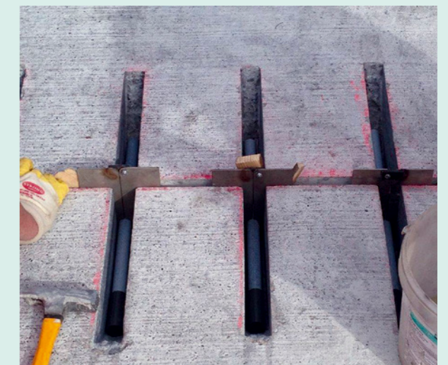
Fugenschalung mit eingelegtem Dübel
