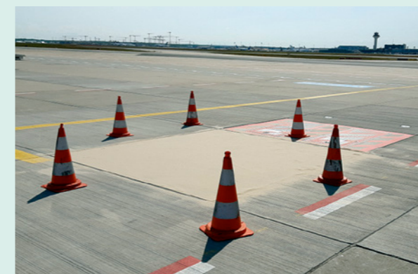
Oberfläche nach Abstreuerung
