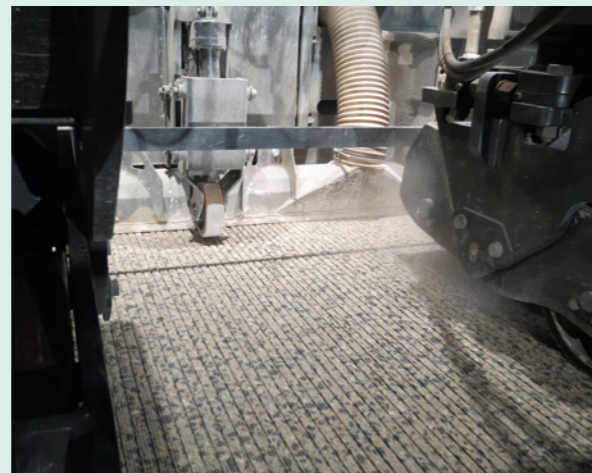
Reinigung der Oberfläche durch Direktabsaugung
