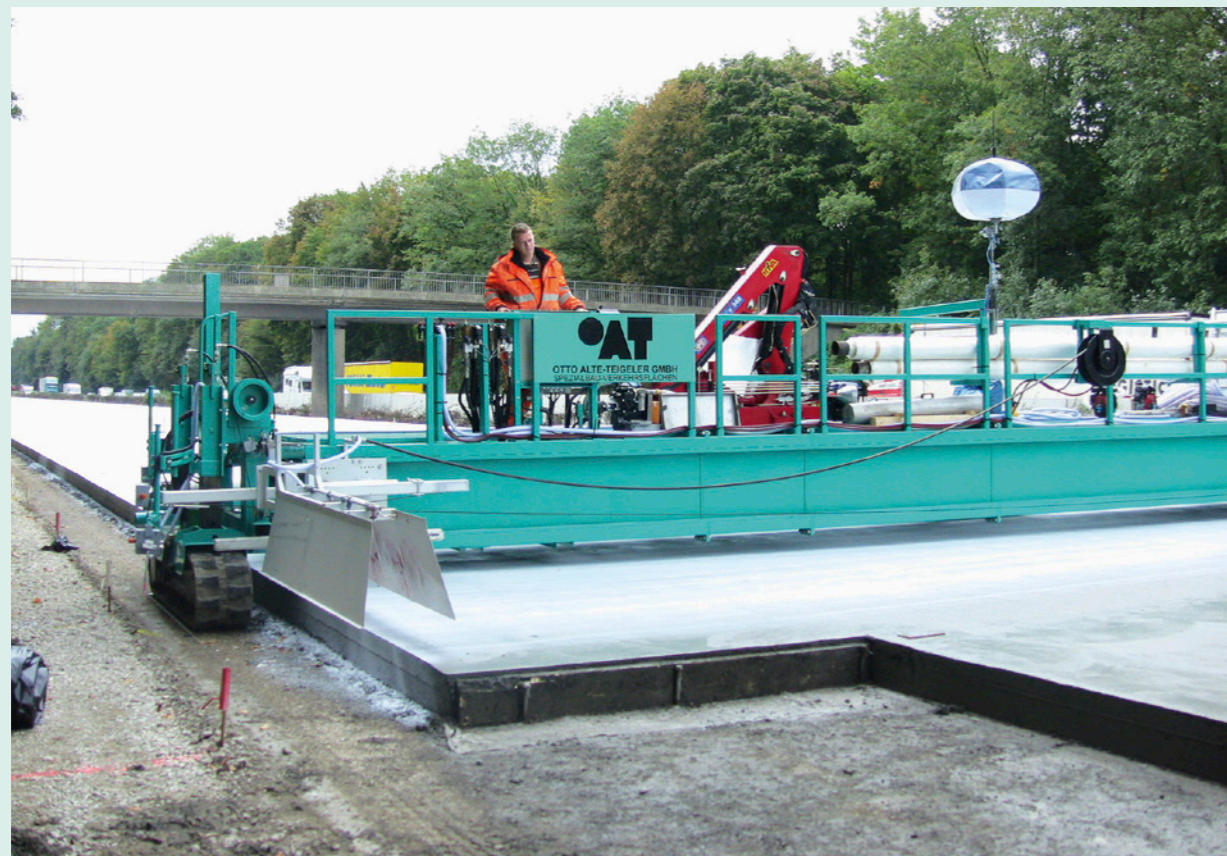
Aufbringen des Kombinationsmittels
