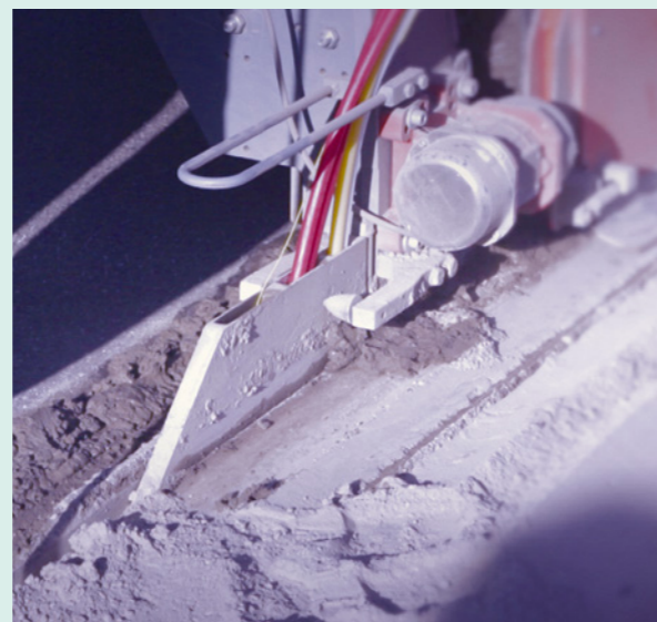
Einlegen der Leerrohre in flexibler Kombination gemäß Bedarf
