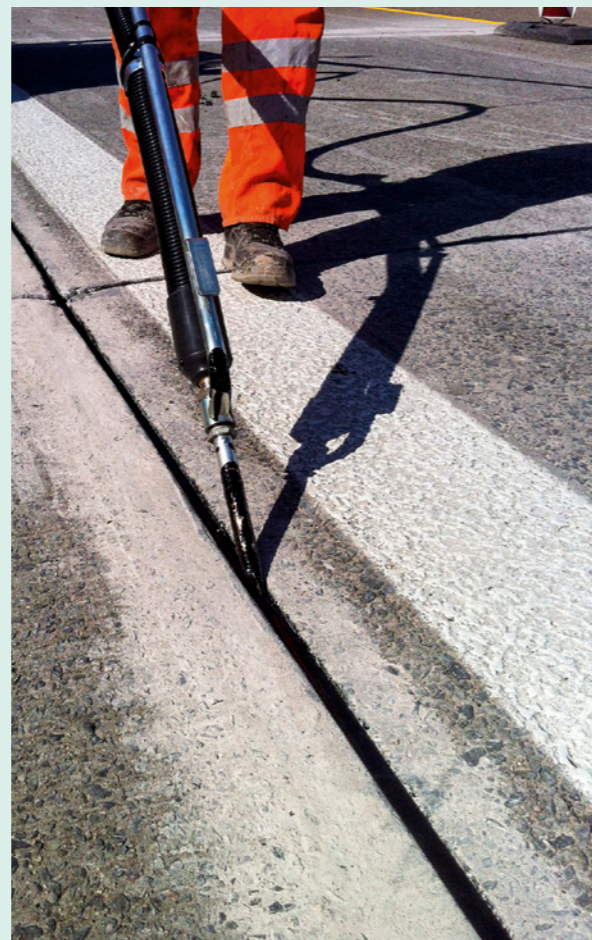
Verguss einer Längsfuge
