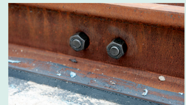
Untergossene Schiene
