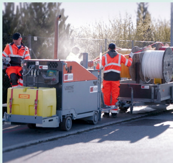
Einbauzug zum Schneiden des Schlitzes und direkten Einlegen der Leerrohre
