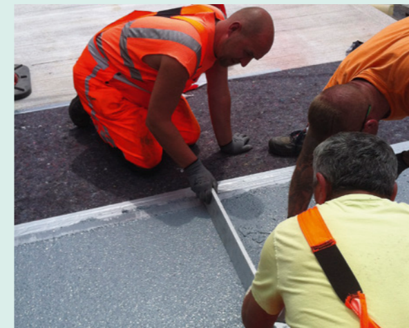
Oberflächenbearbeitung der Belagsdehnfuge
