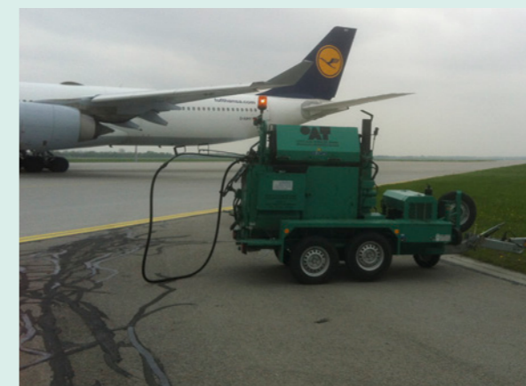
Ergebnis der Sanierung im Rissabdeckverfahren
