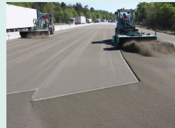
Entfernen des Oberflächenmörtels
