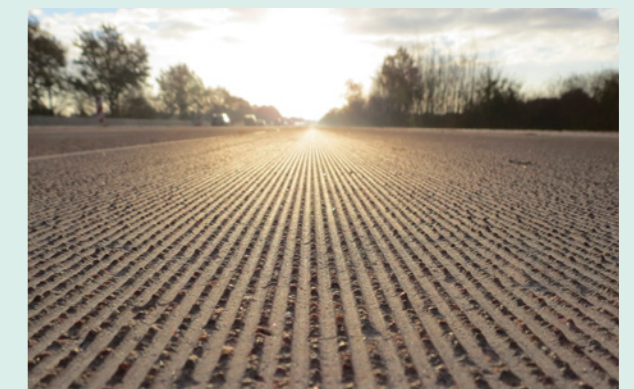
Fertige Grindingoberflächentextur
