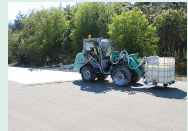
Wiederholte Nachbehandlung des Betons
