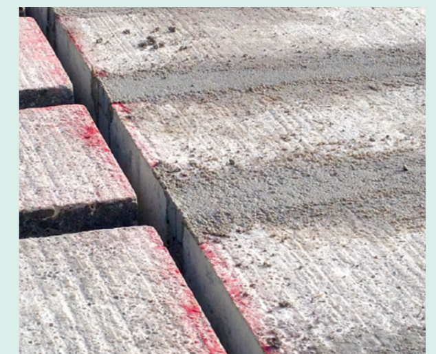
Vorbereitete und fertige Verdübelung
