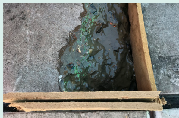
Fugenschalung gegen Brückenbildung
