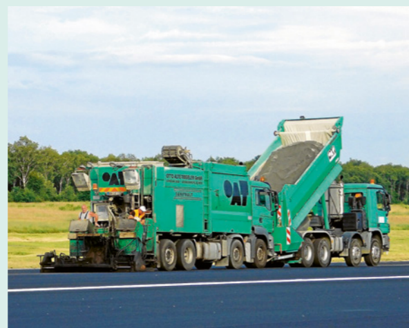
Kontinuierliche Verlegung durch permanente Zufuhr der Zuschlagstoffe
