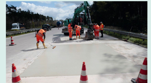
Herstellung der Oberflächentextur
