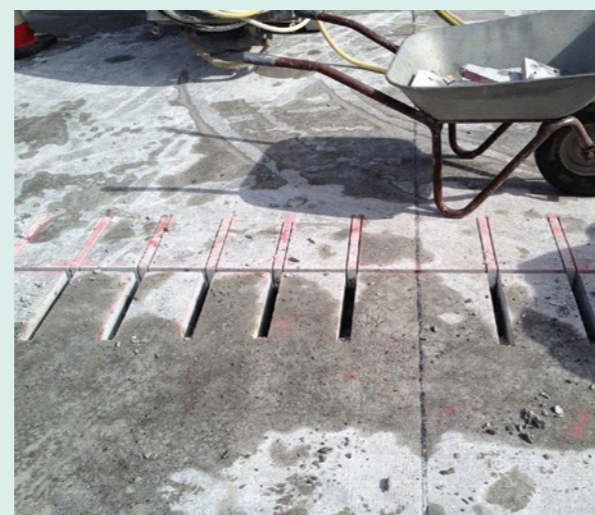
Ausbrechen der Schlitze
