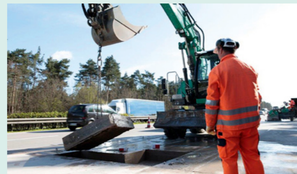
Erschütterungsfreier Ausbau der Betonplatte
