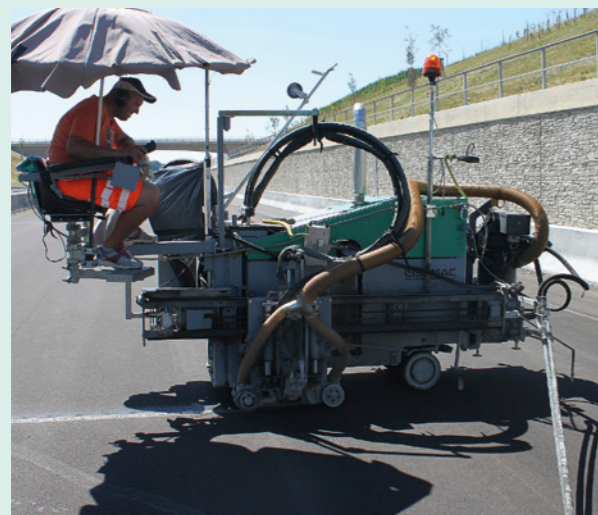
Schneiden der Fuge
