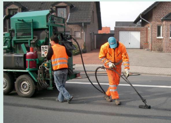
Aufheizen der Rissvergussmasse
