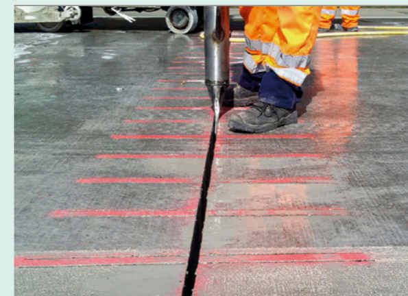
Ausräumen der Raumfuge
