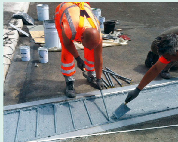
Einbau der Stabilisierungselemente
