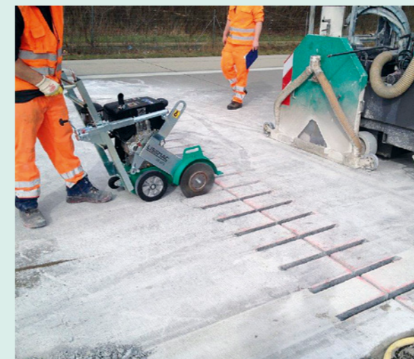
Reinigung der Schlitze
