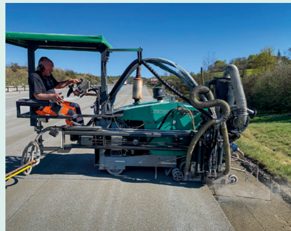
Herstellung des Kerbschnitts – Fugenschneider mit Queranbausatz
