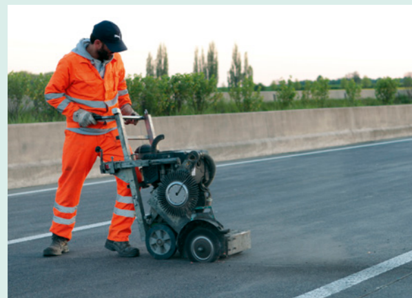
Reinigen der Fuge
