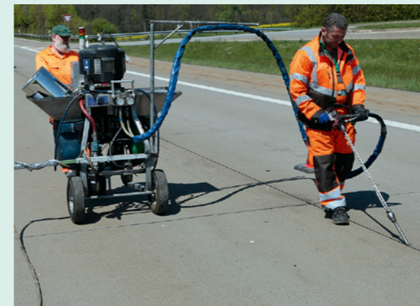
Automatisierte 2K-Fugenvergussanlage
