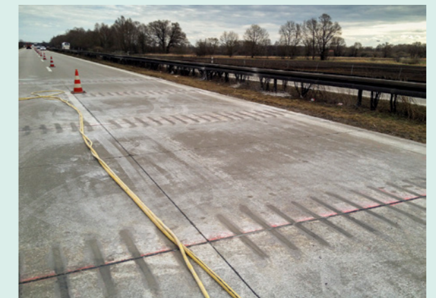
Raumfugen zur Entspannung der Betondecke
