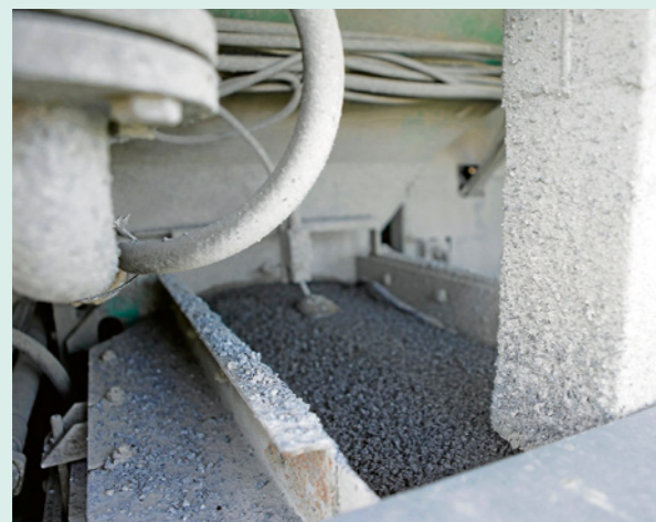
Computergesteuerte Zufuhr der Zuschlagstoffe über Bandwaage je nach Erfordernis
