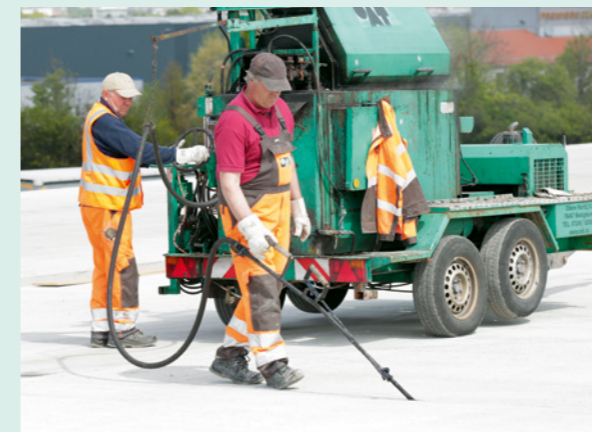
Verfüllen mit bituminöser Fugenmasse
