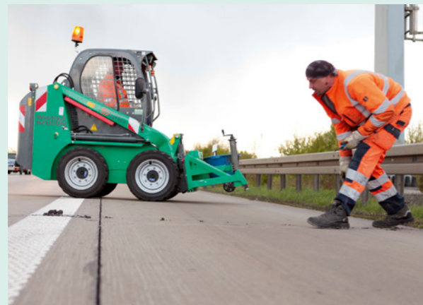
Entfernen der Fugenfüllung
