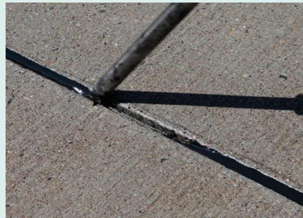
Einbringen der Fugenmasse
