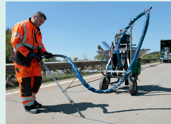
Verfüllen der Querfuge
