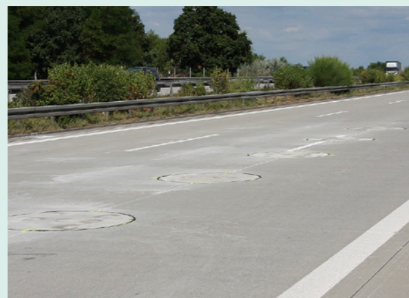
Sanierte Fugenkreuze
