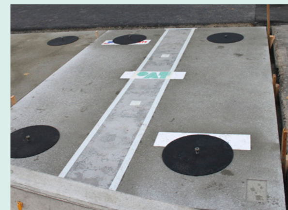
Unabhängige Auflagerung des Fertigteils
