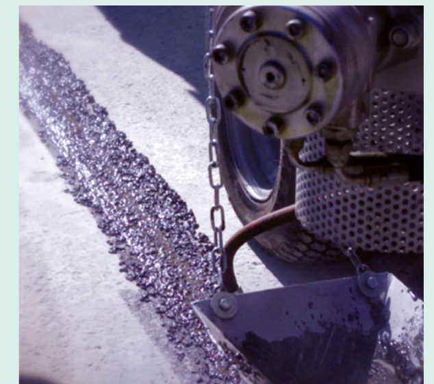
Oberflächenabdichtung mit bituminösem Spezialfugenfüllstoff
