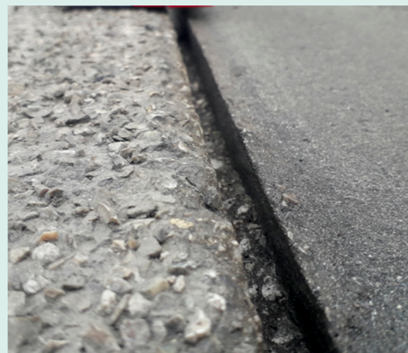
Hergestellte Fugenkammer
