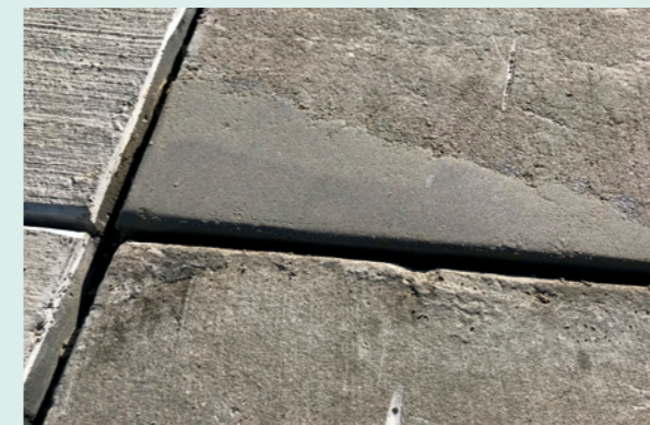
Sanierter Kantenschaden
