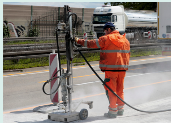
Injektionslöcher mit Einzelbohrgerät
