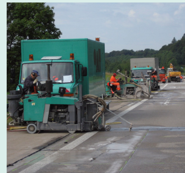
Trennschnitte für Einzelplattenerneuerung
