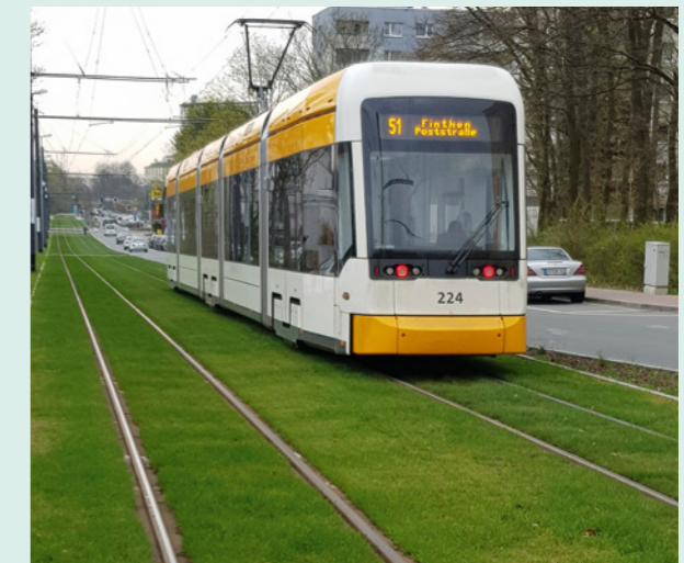
... und nach der Raseneindeckung
