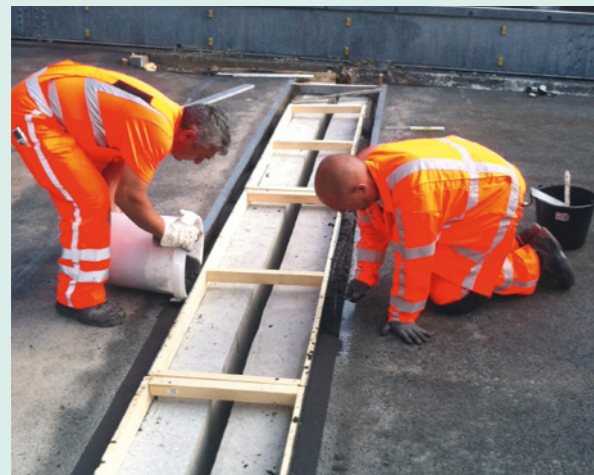
Herstellung der Randbalken
