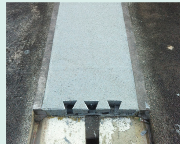
Halbseitig fertiggestellte Belagsdehnfuge
