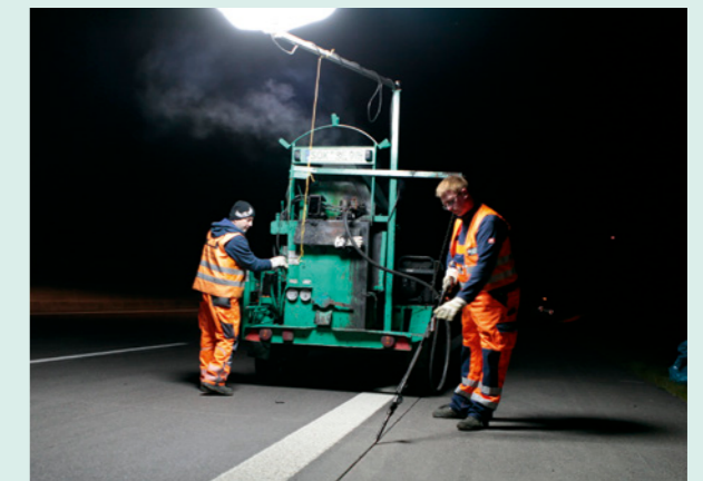
Ausführung in verkehrsarmen Zeiten möglich
