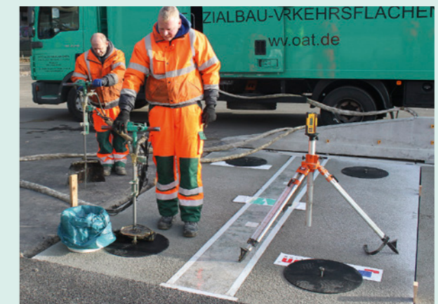
Überwachung der Unterpressarbeiten
