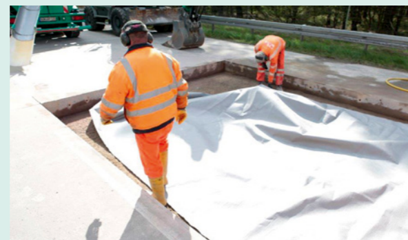
Vorbereitete Tragschicht mit Zwischenlage
